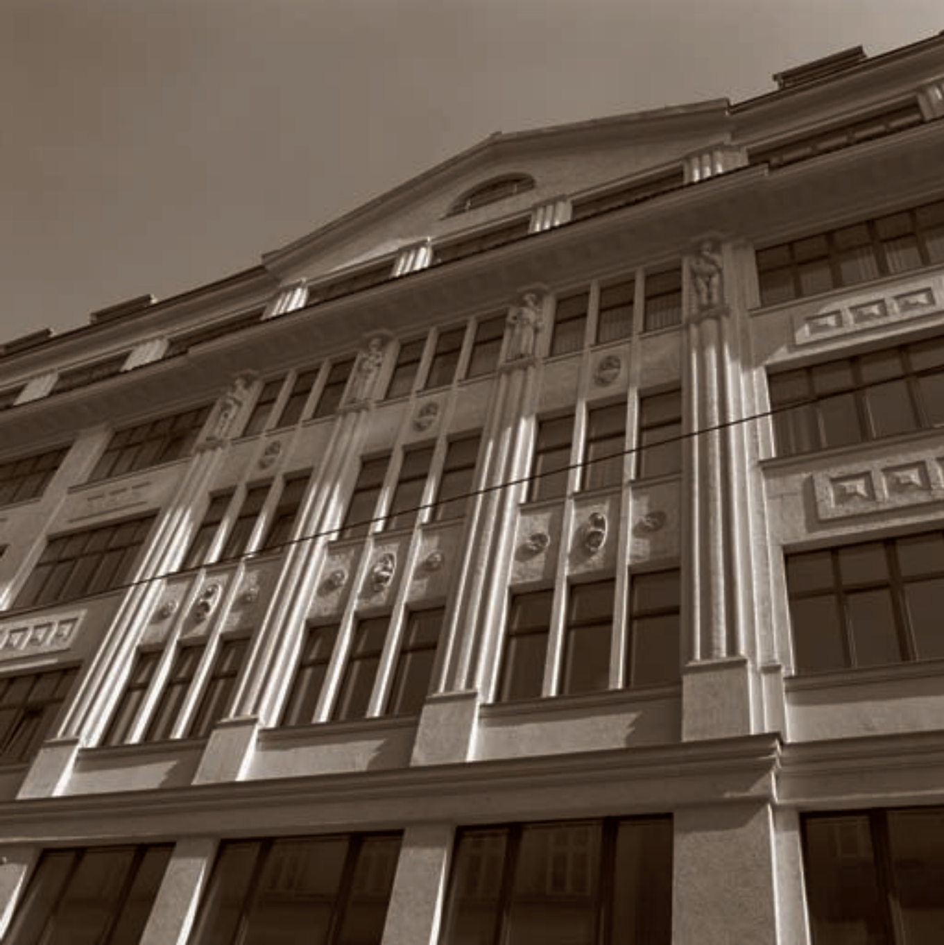
Die neuen Büroräumlichkeiten in Wien 7., Kirchberggasse 33
