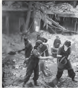
1945 Wiederaufbauarbeiten in Wien
